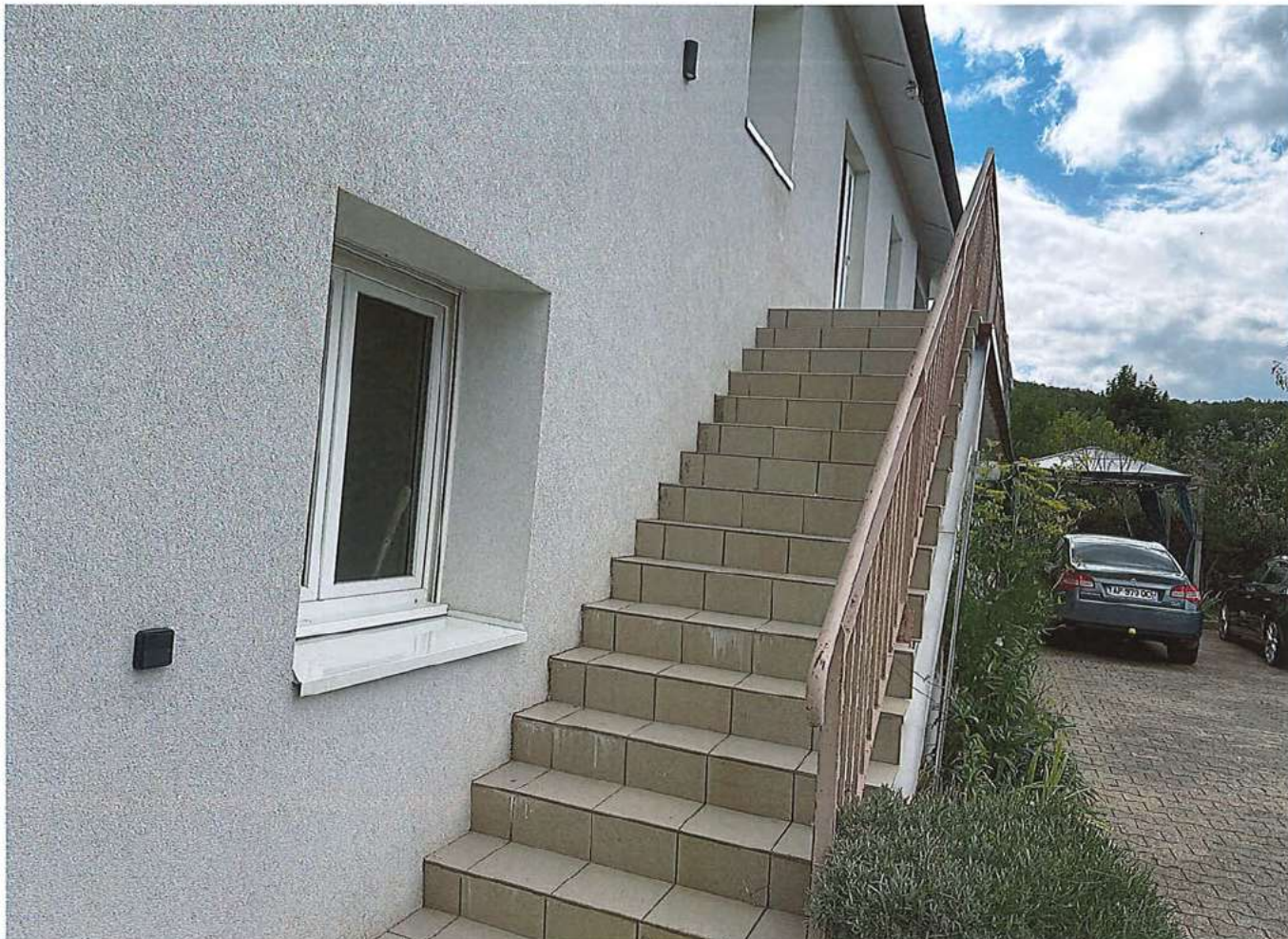
Escalier accès 2 e étage
