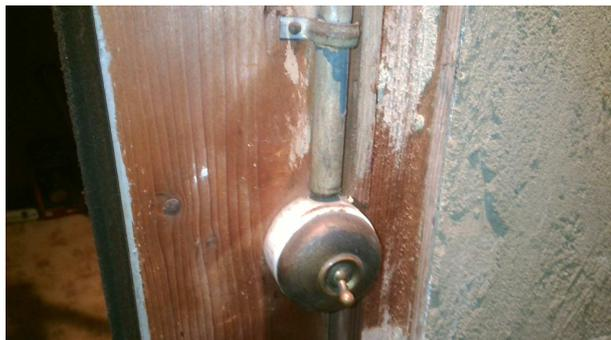
La section des CONDUCTEURS de la CANALISATION alimentant le seul tableau n'est pas adaptée au courant de réglage du DISJONCTEUR de branchement.
