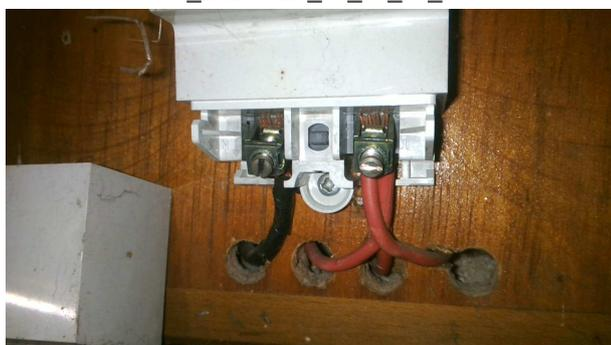
A l'intérieur du tableau, la section d'au moins un conducteur alimentant les dispositifs de protection n'est pas adaptée au courant de réglage du disjoncteur de branchement.
